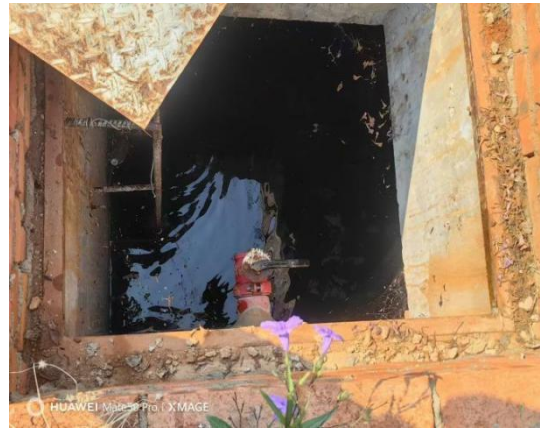
图片 2 消防水池
