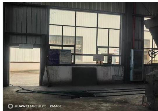
图片 5 锅炉房消防栓箱及应急疏散标识
