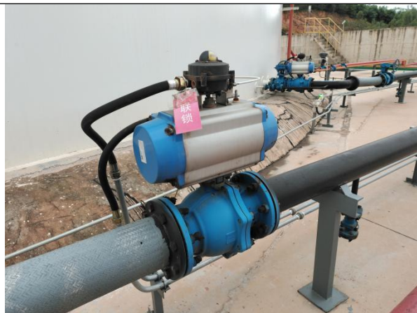
照片 5 SIS 切断阀
