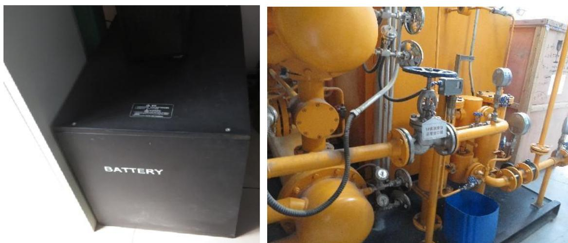
图 13 自动控制系统不间断供电电源、润滑油箱照片
