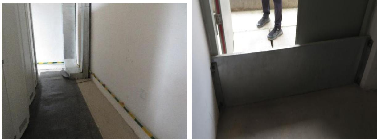
图 15 配电绝缘胶垫、接地装置及挡鼠板
