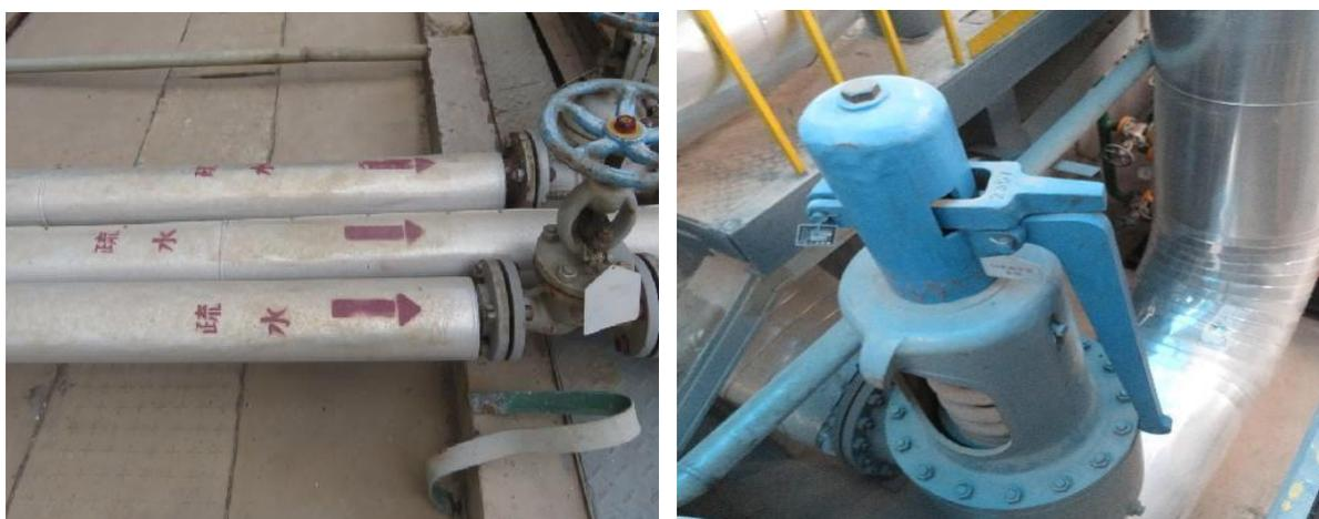
图 16 管道标识照片及安全阀
