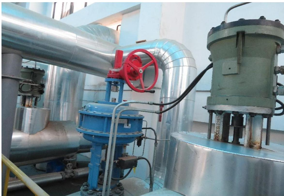
图 11 蒸汽入口切断阀
