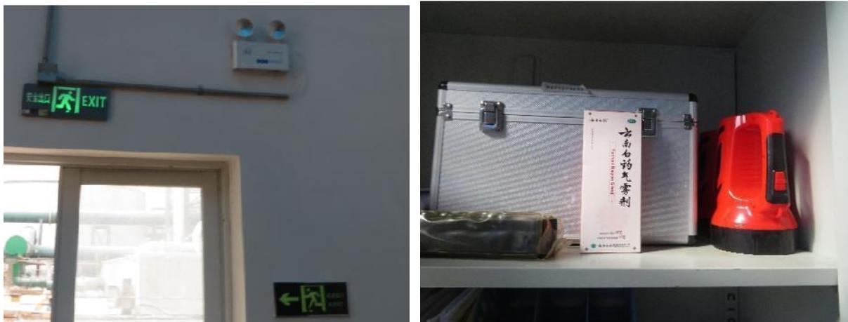
图 18 厂房内应急照明灯、机柜间应急器材
